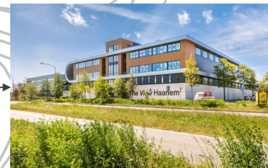
Meerlaags bedrijfsverzamelgebouw De View, Haarlem
