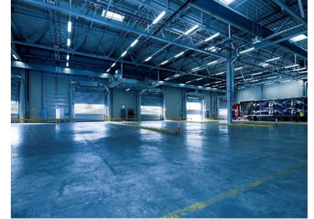
Gemeenschappelijk overdekt truck loading dock.
