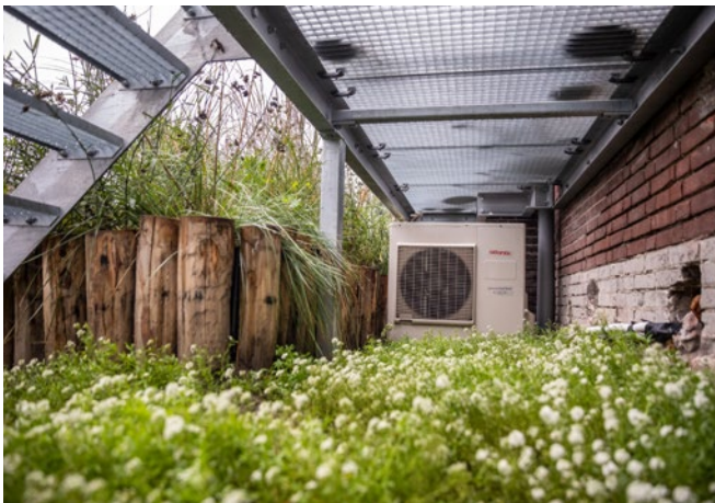
Buiteneenheid lucht-water warmtepomp
