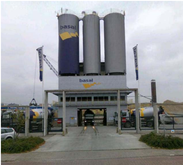
Figuur 1: Betonmenginstallatie Dyckerhoff Basal
