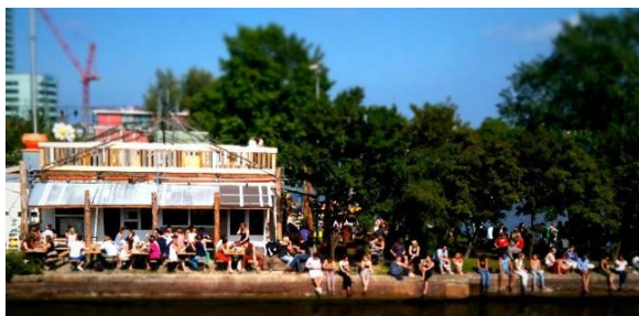
Figuur 7.5 – Tijdelijke horeca in een tijdelijk gebouw
