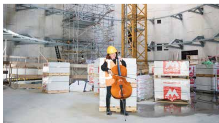
De bouwplaats van het OCC is voor het eerst open voor publiek.
